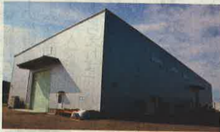
1月から稼働している南相馬工場
